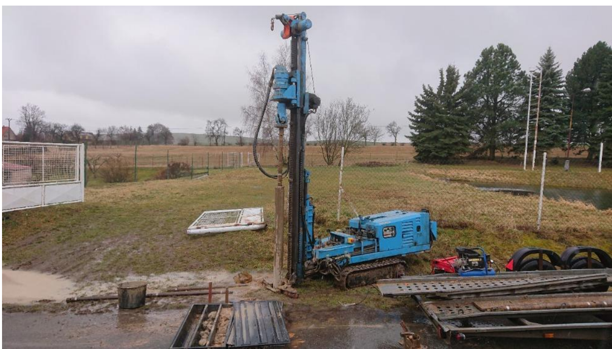
Prostor průzkumu, vrtné práce, sonda JV5
