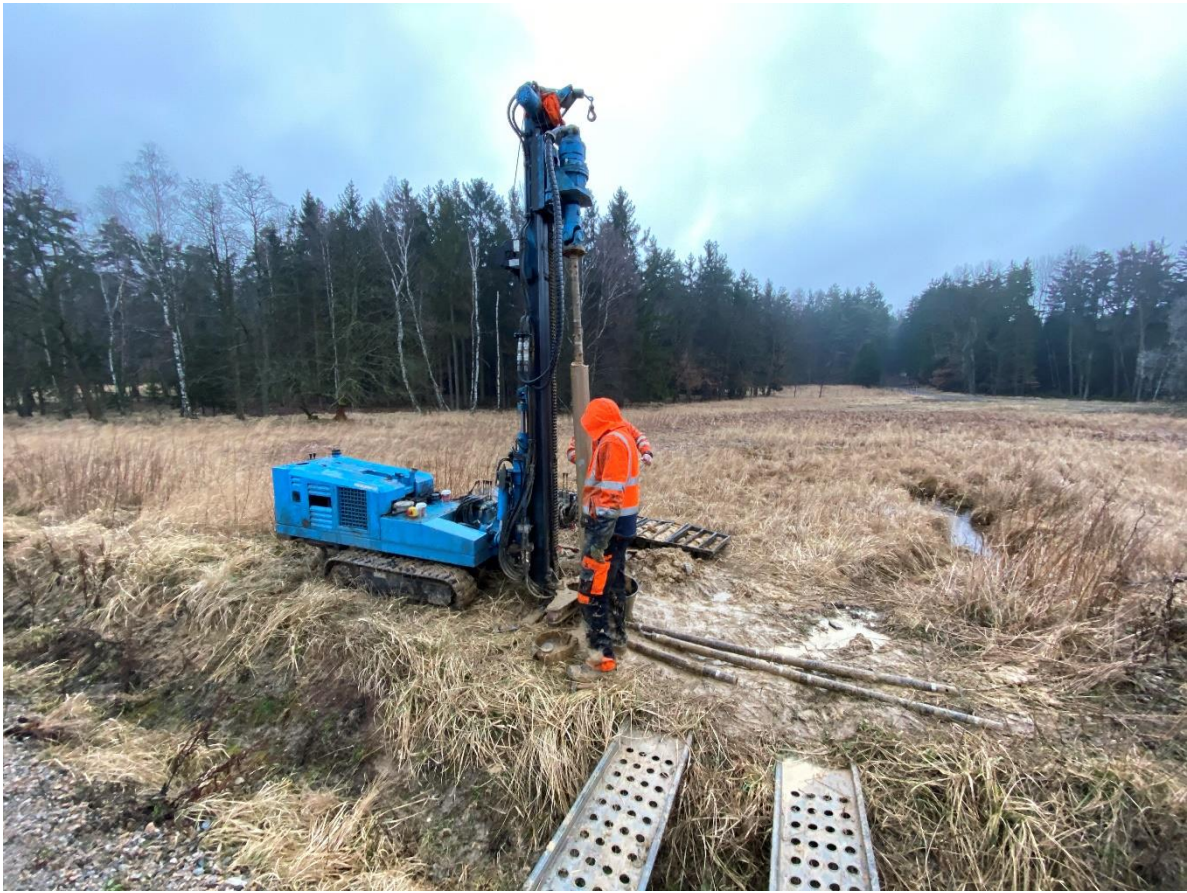
Prostor průzkumu, vrtné práce, sonda JV4
