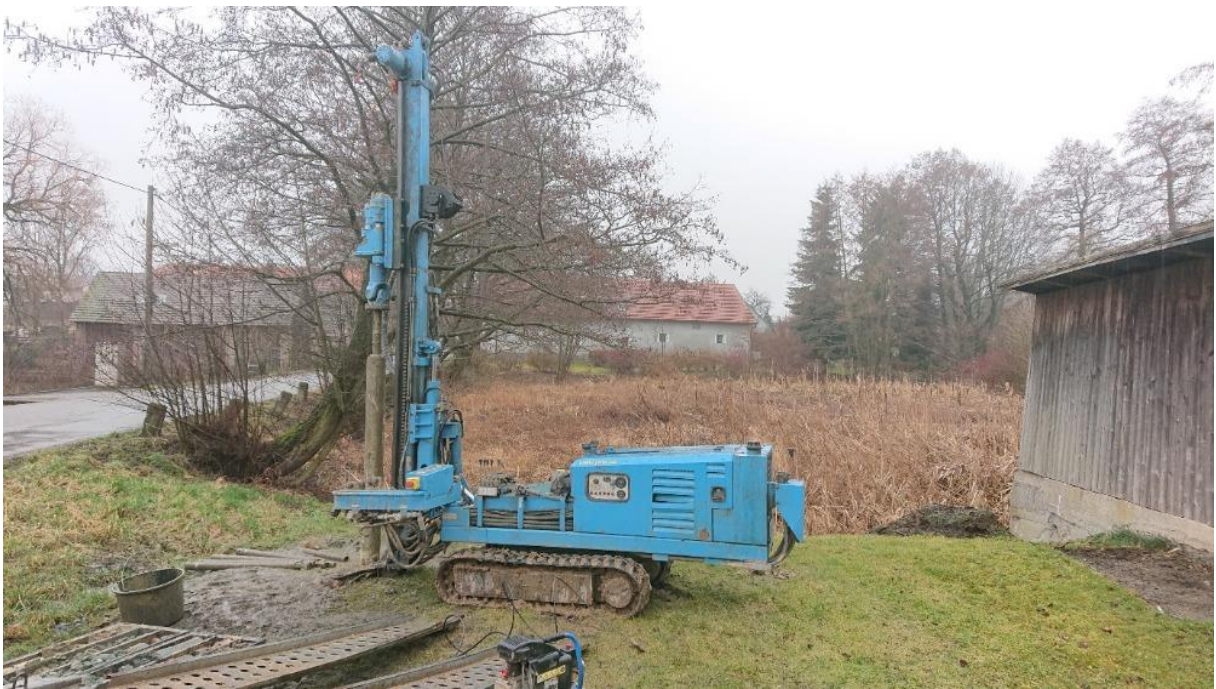
Prostor průzkumu, vrtné práce, sonda JV6
