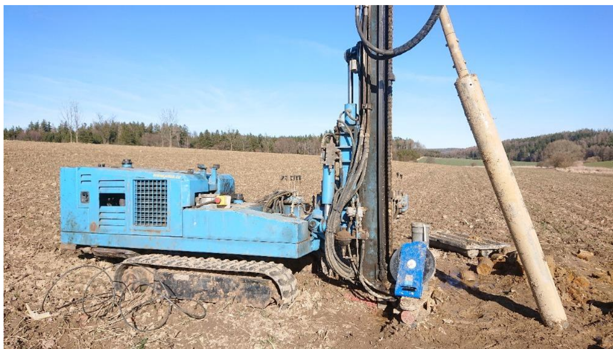
Vrtné práce, vsakovací zkouška, sonda JV1
